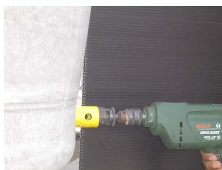
ii) Hacer un tercer agujero con diámetro de 25mm en una pared perpendicular a los dos agujeros anteriores. El centro de ese agujero puede estar a una altura máxima a la mitad de la altura total del tanque. Instalar en ese agujero el adaptador soldable con bridas de 25mm para distribuir el agua calentada para la ducha.
